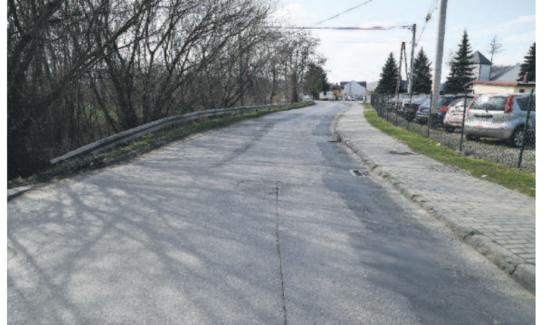
Ulica Pomianowska również sporo „ucierpiała” podczas budowy brzeskiego łącznika – fot. Krzysztof Wójcik
